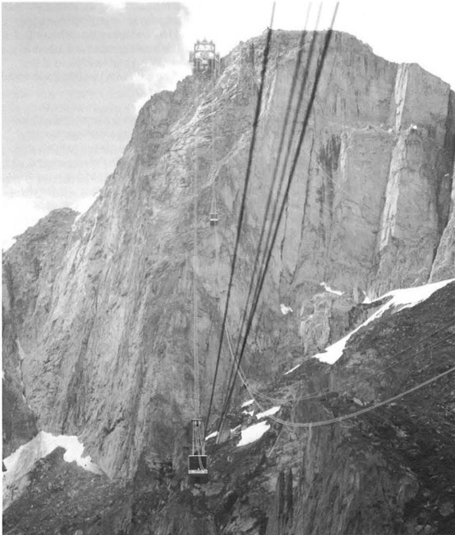
Die erst vor drei Jahren erneuerten Tragseile der alten Seilbahn wurden weiterverwendet, wodurch erhebliche Kosten eingespart werden konnten. Die Spur der beiden Tragseile einer Fahrbahn wurde auf 500 mm erhöht und zur Hochhaltung der Zugseile je Fahrbahn drei Seilreiter eingebaut.
