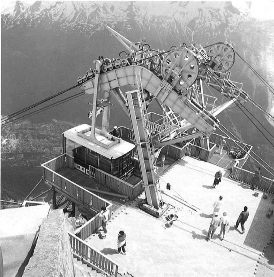
*Die Bergstation ist als Portalpendelstütze in offener Stahlkonstruktion ausgeführt. Das Dach der alten Bergstation dient als Aussichts-Plattform. Die gesamte Bergstation wird durch vier Abspannseile gehalten.*
