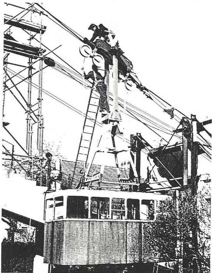
Gare inférieure - vue d'ensemble
