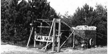
Abb./Fig. 4: Antriebsstation für zweispurige Pendelbahn P 300 (Militärseilbahn). / Drive terminal of the two-track reversible P 300 (military ropeway). / Station motrice d'un téléphérique à va-et-vient à deux voies coaxiales P 300 (téléphérique militaire).
