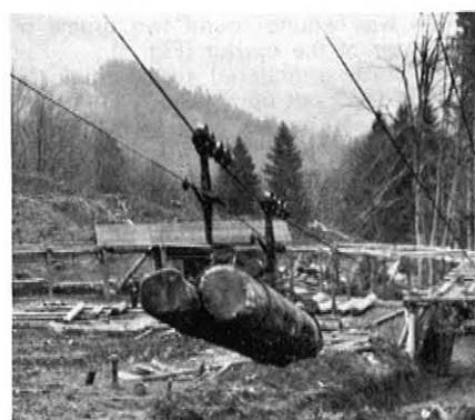
Abb./Fig. 2: Zweiseilumlaufbahn zur Holzbringung, Puchenstuben, Länge 7 km, Einzellast max. 20 kN, Stämme bis 22 m Länge. / Bicable circulating ropeway for timber transport, Puchenstuben. Length 7 km, max. carrier payload 20 kN, tree trunks up to 22 m in length. / Téléphérique bicâble à mouvement continu, pour le débardage, à Puchenstuben; longueur: 7 km; charge maxi. en un point: 20 kN; troncs de 22 m le long.
