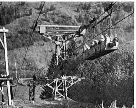
Abb./Fig. 8: PB Käfertal: Materialseilbahn mit Werksverkehr für Tauernkraftwerke. / PB Käfertal. Material ropeway for Tauernkraftwerke. / Téléphérique de Käfertal: téléphérique à matériaux, à va-et-vient, pour la centrale des Tauern.
