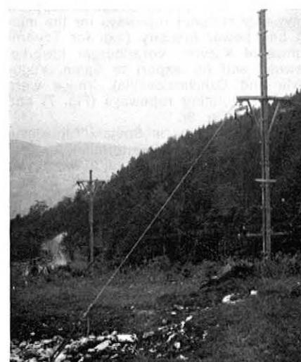
Abb./Fig. 3: Höhenverstellbare Stütze einer militärischen Feldseilbahn, mit Seilen abgespannt. / Vertically adjustable guyed tower of a military field ropeway. / Pylone de hauteur réglable, pour téléphérique militaire de campagne; avec câbles de haubanage.
