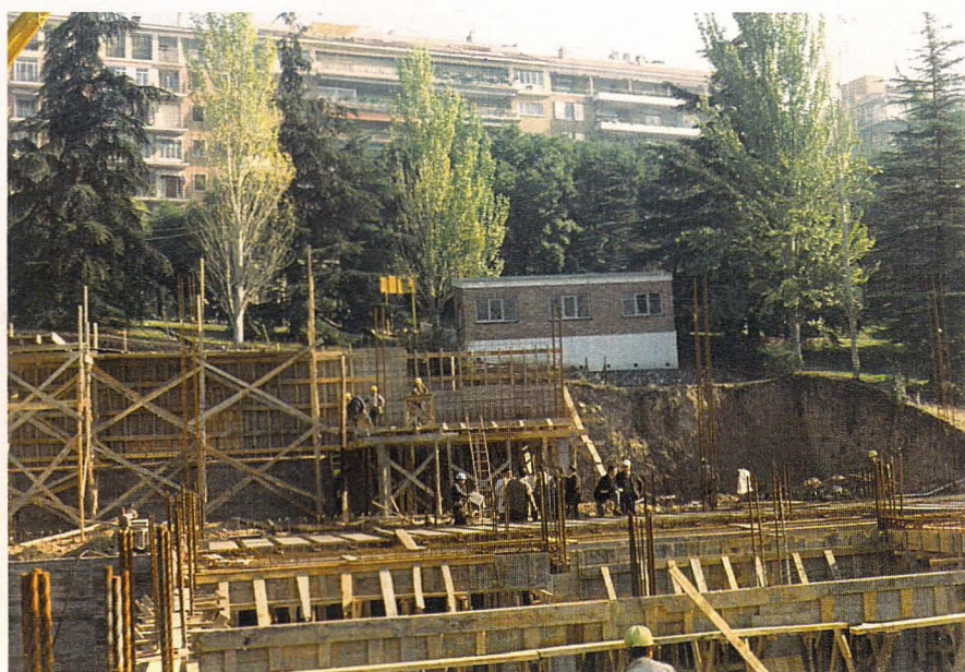
Construcción de elementos portantes
