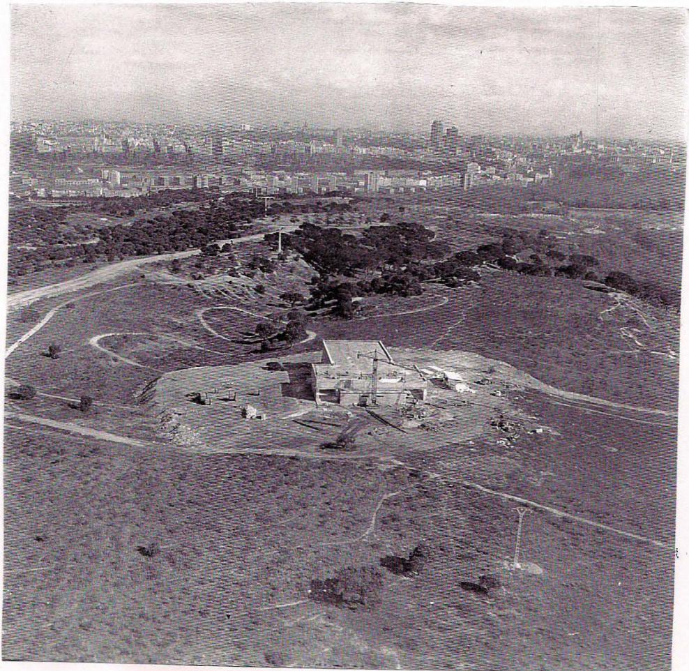
Construcción de la Estación de Casa de Campo (Nov. 68)
