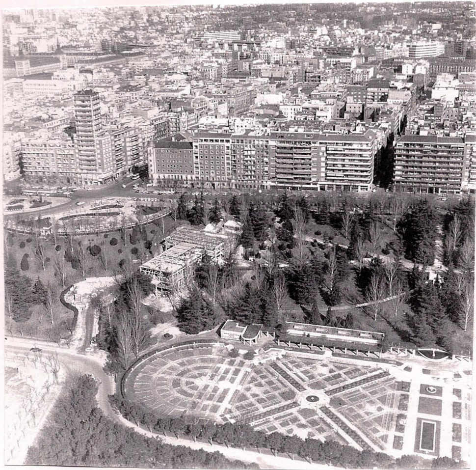
Construcción de la Estación de Rosales (Nov. 68)
