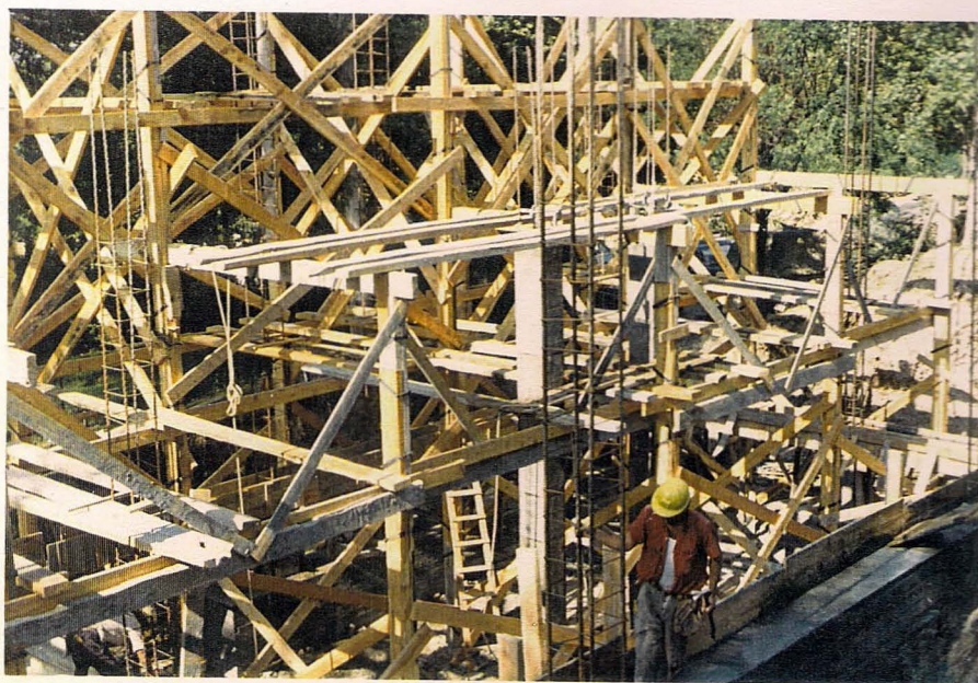
Detalle de la utilización de andamiaje de madera
