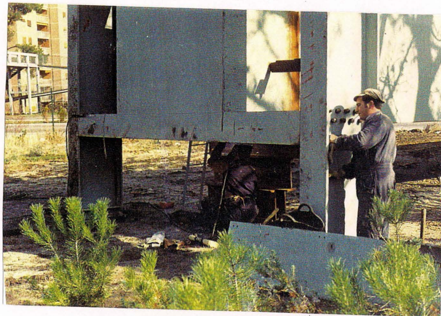
Ajustes en la base de la pila junto a la M-30
