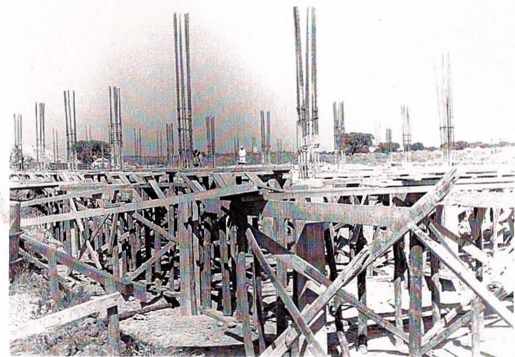
Construcción de la estructura de la Estación Casa de Campo
