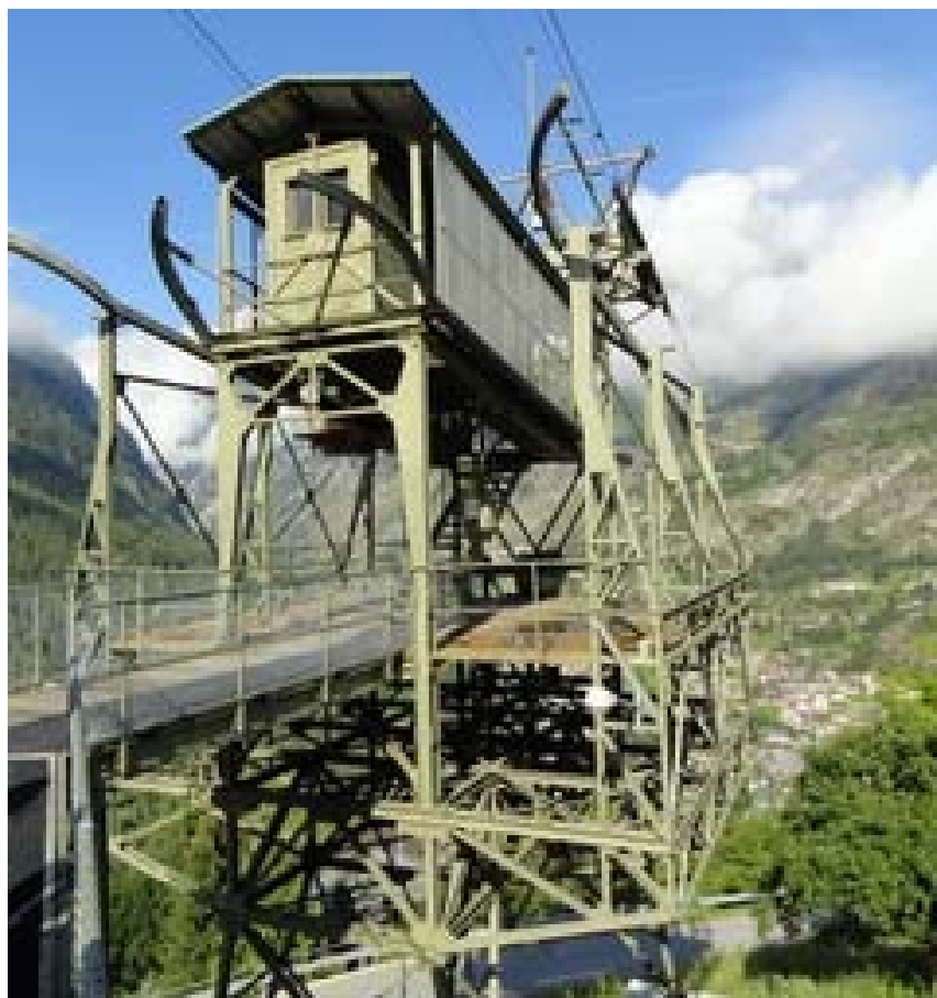
Figure 4 – Station intermédiaire « Zur Kirche »
