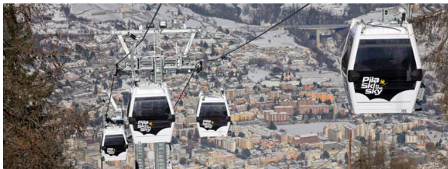
Figure 2 - Liaison par câble Aoste - Pila
