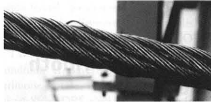
Fig. 2 : Des fils externes se sont relâchés par suite du desserrage du câble.
