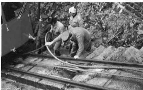
Fig. 1 : Sur un câble qui s'était desserré à la suite d'un essai des freins le vrillage a provoqué la formation d'une boucle. Il faut la défaire avec précaution, sinon elle se ressermera et formera une coque risquant de provoquer la rupture du câble.
