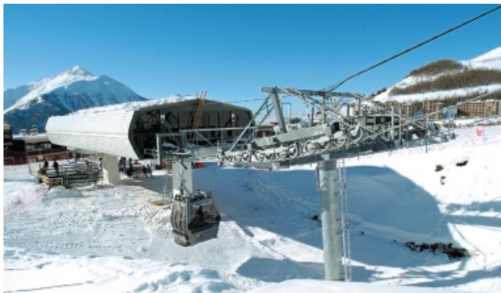
L'appareil réalisé par POMA à ORCIERES est le premier d'un nouveau type d'appareils, qui réussit la mixité télésiège et télécabine. Cet appareil est équipé des premières cabines DIAMOND 8 installées en France.
