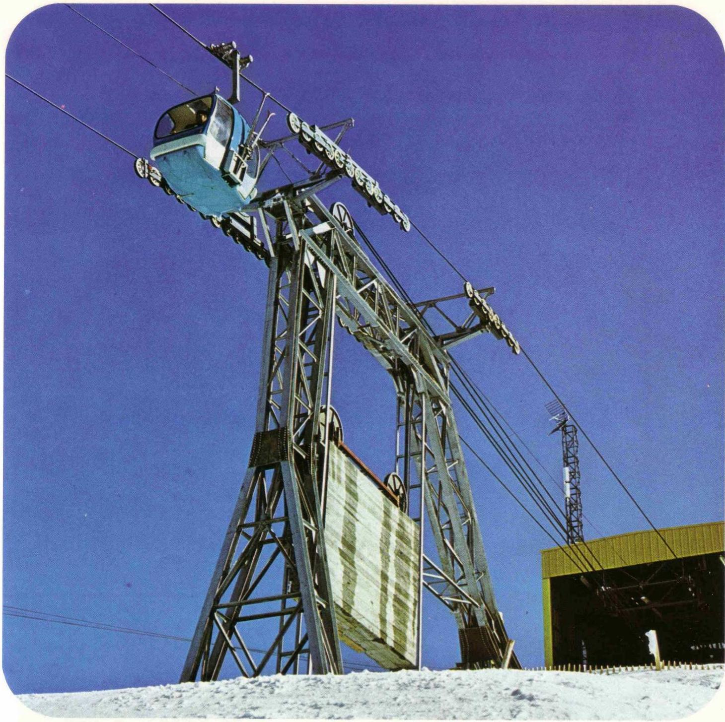
Les balanciers, suivant la charge utile qu'ils ont à supporter, sont constitués d'un nombre pair de galets, allant de 4 à 16. Ces galets légers ( $\varnothing$  320 mm ou 420 mm), articulés deux par deux, sont munis de bandages en caoutchouc à haute résistance, qui ont pour but d'assurer une grande douceur de passage à l'endroit des pylônes.
